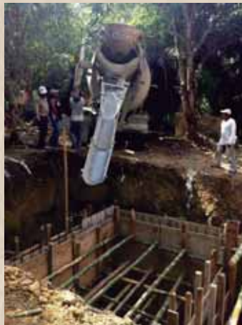
Construcción de pozo de absorción
