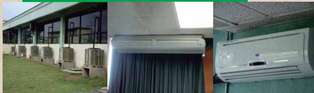
Instalación de aires acondicionados mini Split
