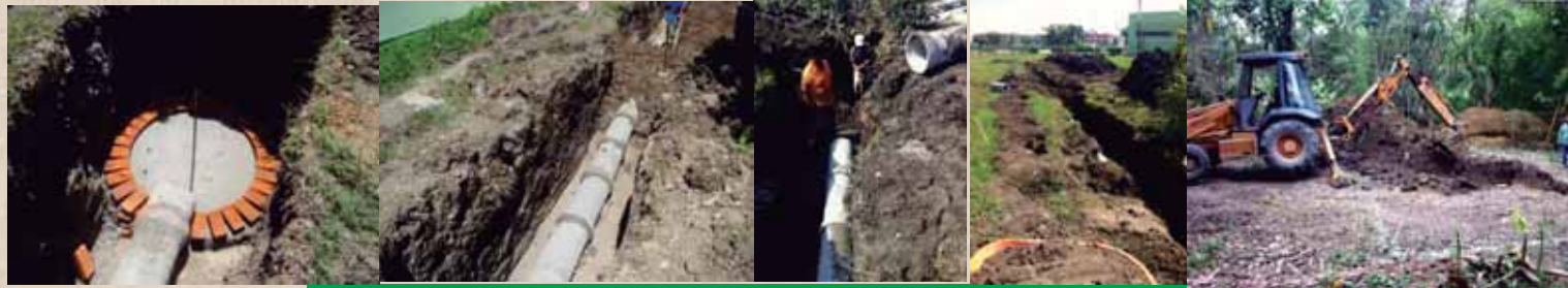
Construcción de red de drenaje sanitario
