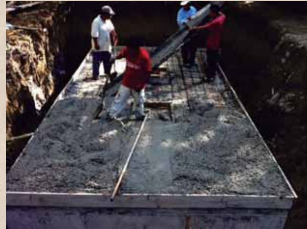
Construcción de pozo de absorción
