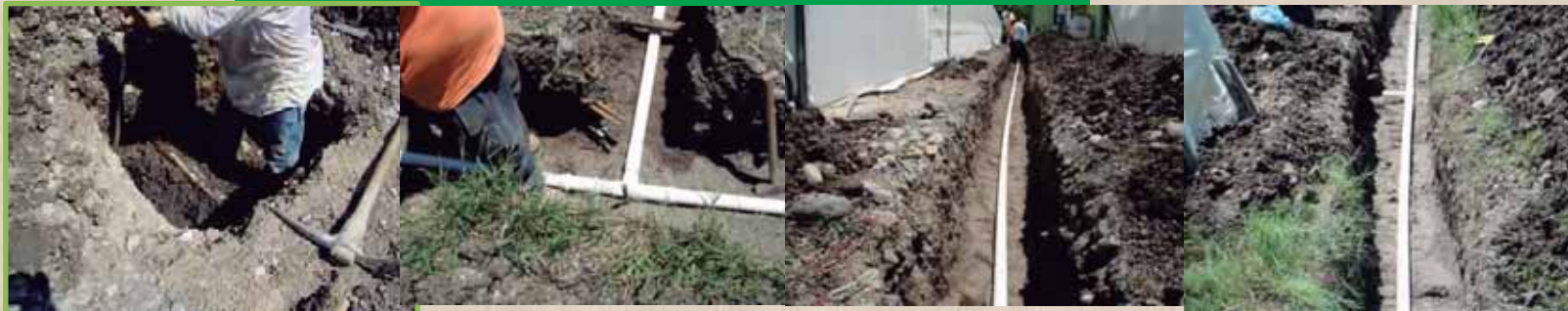
Construcción de red de agua potable
