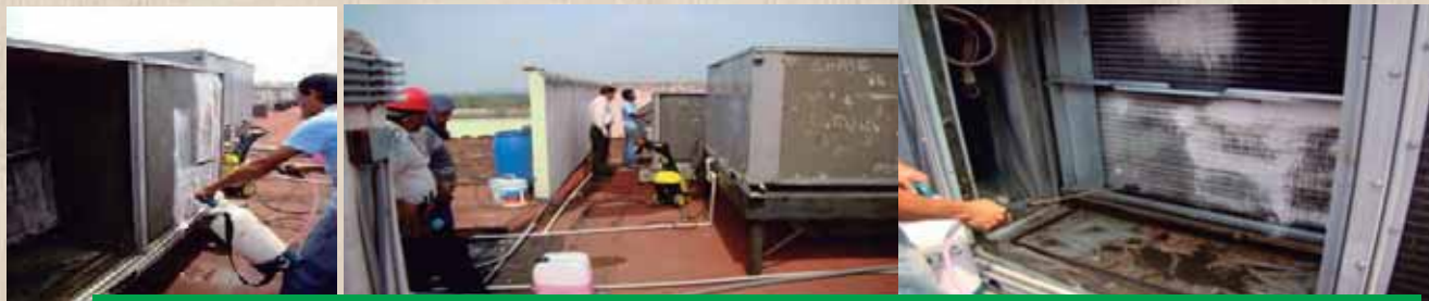
Mantenimiento sistema de aires acondicionados modulares
