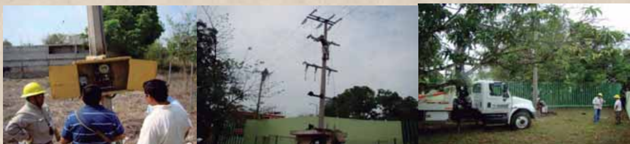
Mantenimiento de red eléctrica y subestaciones
