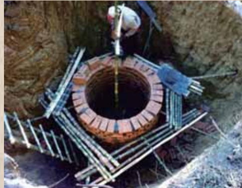
Construcción de pozo de absorción
